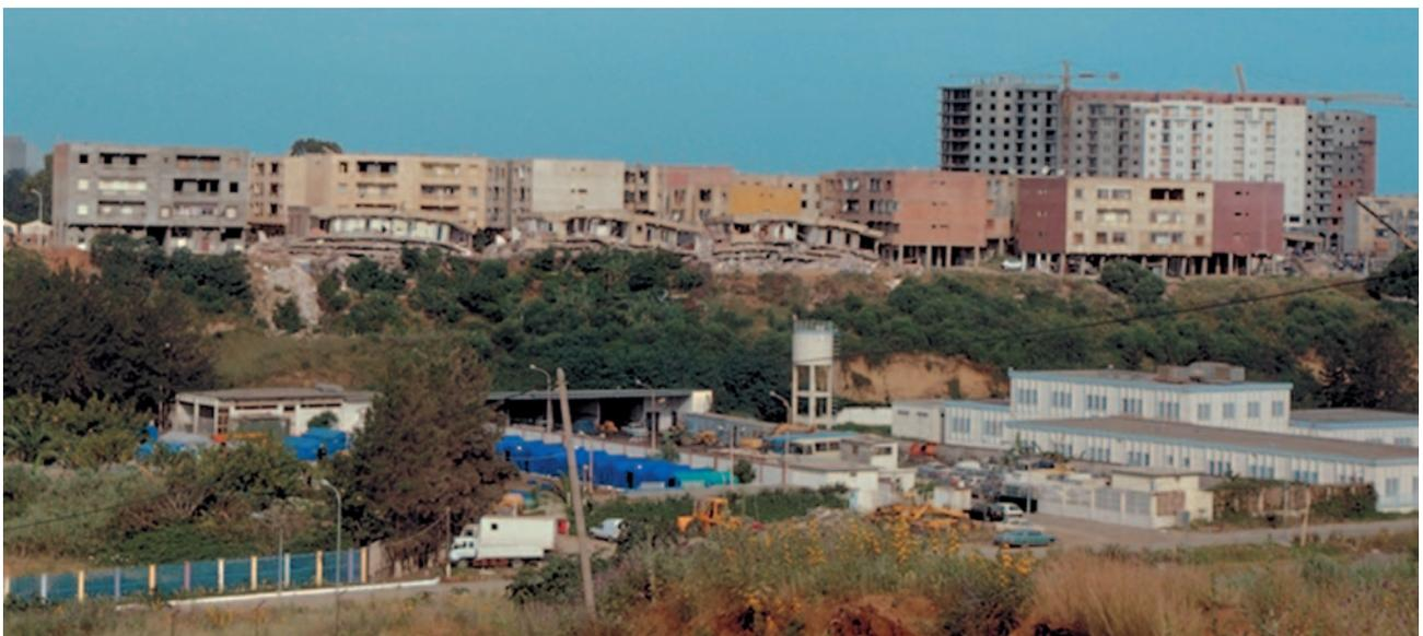
Figure 12: Effet de site topographique du séisme d'Alger/Boumerdès (2003) avec concentration des dégâts sur les bords des falaises surplombant la vallée.
