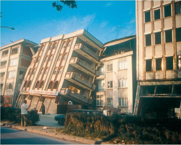
Figure 16: Enfoncement d'un immeuble vers l'arrière suite à la liquéfaction de son sol de fondation (séisme d'Izmit, Turquie, 1999).
