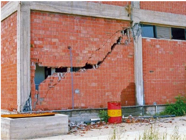
Fig. 1.4: Dommages à des colonnes causés par le remplissage en maçonnerie, Turquie, séisme de 1998
