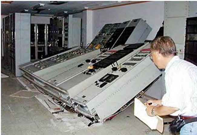
Fig. 2.13.1 et 2.13.2 > Armoires de commande renversés
