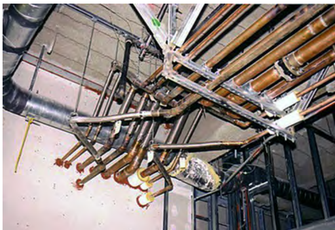
Fig. 2.18.10 > Raccords flexibles au droit de traversées murales, contreventement de voies de conduites
