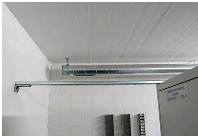
Fig. 2.13.5 > Fixation d'armoires/boîtiers autonomes sur pieds
