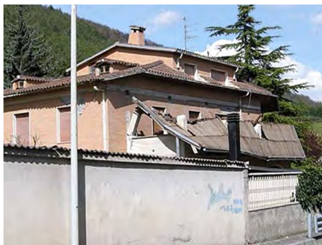
Fig. 2.9.2 > Avant-toit effondré
