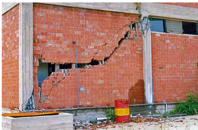
Fig. 2.4.1 > Rupture d'une diagonale sollicitée en compression dans la maçonnerie et endommagement des colonnes en béton armé
