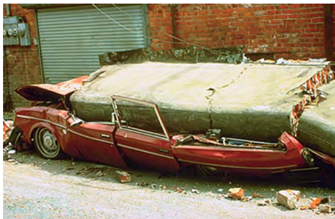
Fig. 2.6.1 et 2.6.2 > Effondrement sous l'effet de forces d'inertie transversales au plan du parapet
