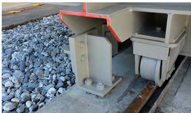
Fig. 2.14.3 > Fixation d'un transformateur monté sur roues
