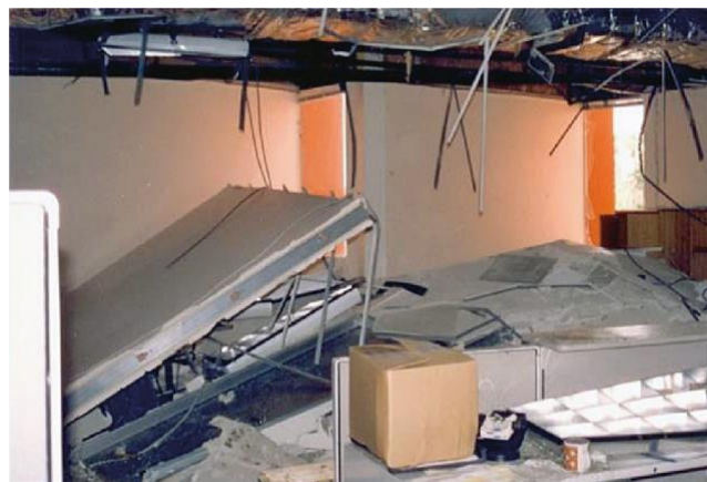
Fig. 1.2 Cloisons renversées, éléments de plafond et luminaires tombés à terre, séisme de Northridge, 1994
