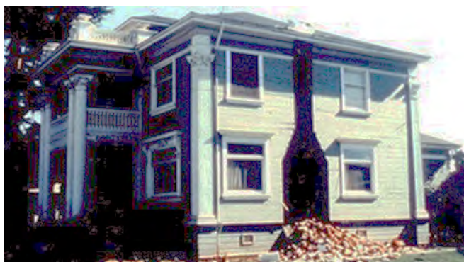
Fig. 2.10.1 > Effondrement d'une cheminée
