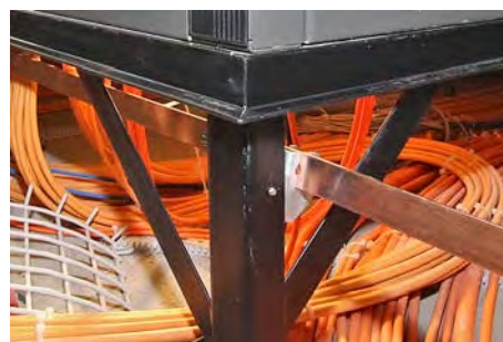
Fig. 2.3.8 > Stabilisation horizontale par barres diagonales
