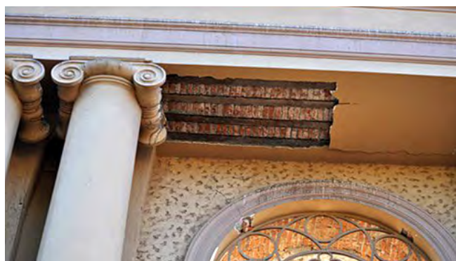
Fig. 2.10.2 > Tuiles tombées à terre
