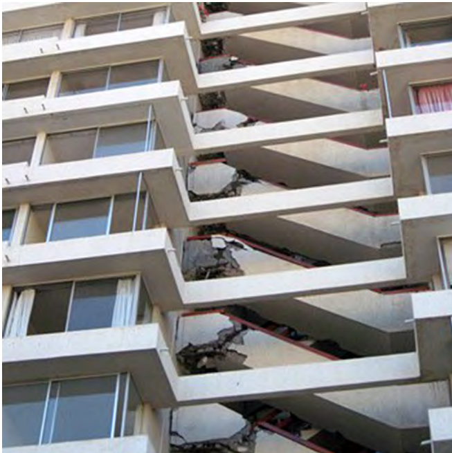
Fig. 2.7.1 et 2.7.2 > Diagonales de compression dans une volée d'escaliers
