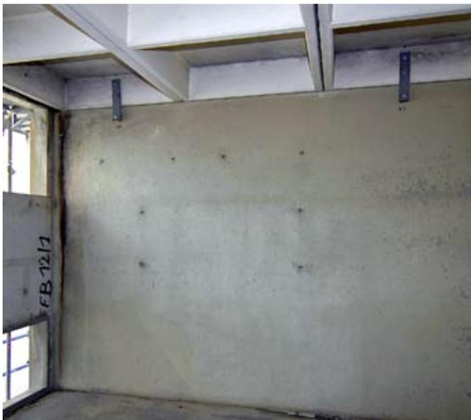
*Attaches appliquées a posteriori pour relier le plancher en caissons aux parois.*
