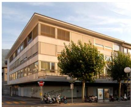
*Bâtiment avec un contreventement asymétrique (exemple 15: bâtiment HPH de l'EPF Zurich).*
