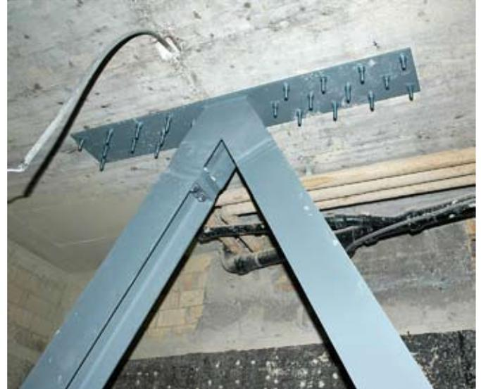
Ancrage d'un nouveau treillis d'acier en «V» dans la dalle du premier étage.
