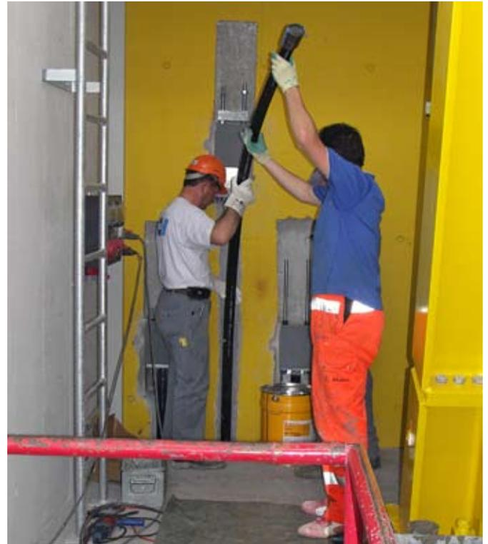
Insertion des lamelles en fibres de carbone pour ancrer les nouvelles parois en béton armé.
