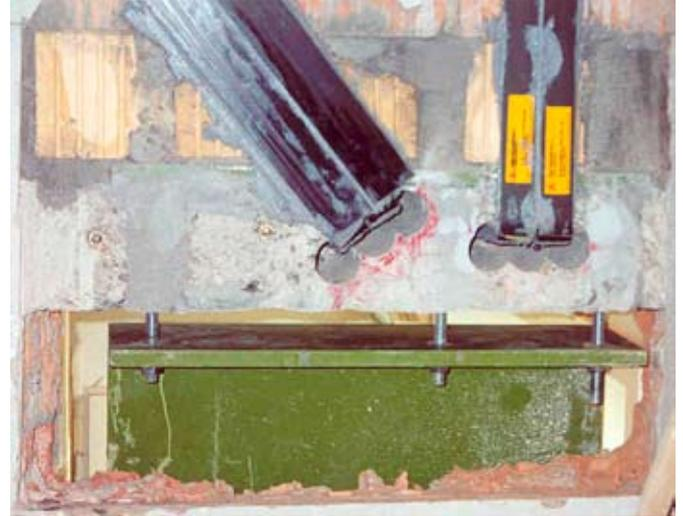
*Ancrage des lamelles en fibre de carbone dans les dalles en béton armé à l'aide de cornières résistant au cisaillement.*
