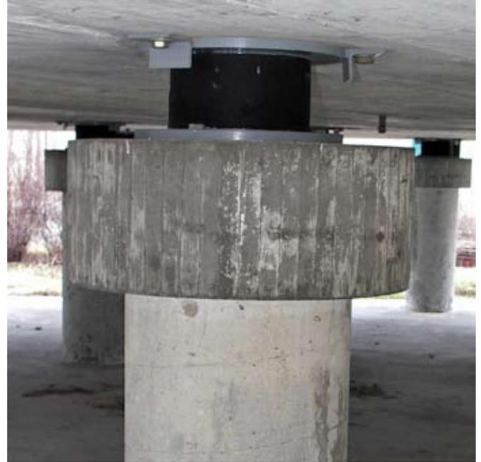
*Appui en caoutchouc spécial intégré sous le réservoir de gaz liquide.*
