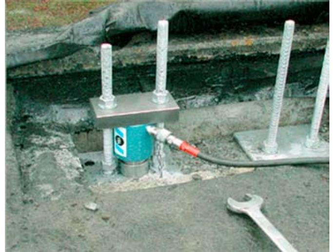
Les lamelles en fibres de carbone sont précontraintes à partir du toit (Truffer et al., 2004).
