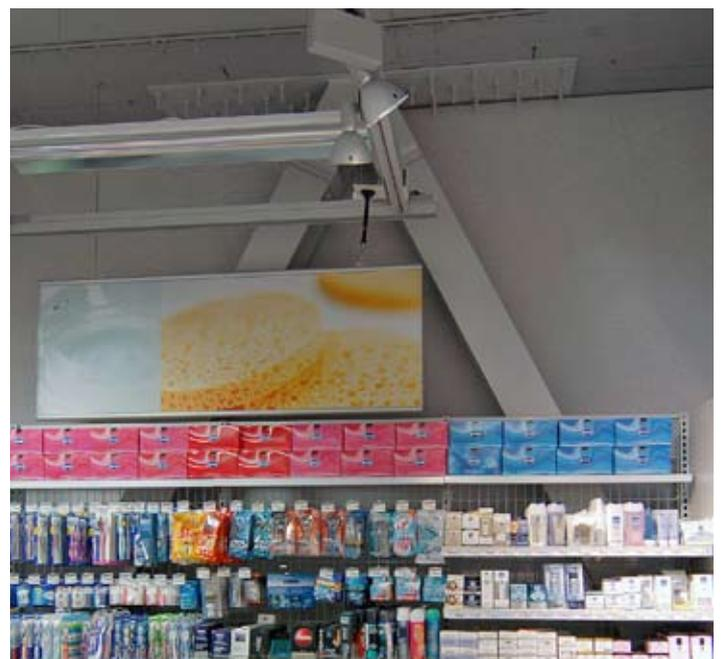
*Nouveau treillis d'acier en «V» caché derrière un rayon de vente du rez-de-chaussée.*
