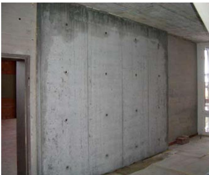
*Renforcement d'une paroi en béton armé existante en y accolant une nouvelle paroi de 15 cm d'épaisseur.*
