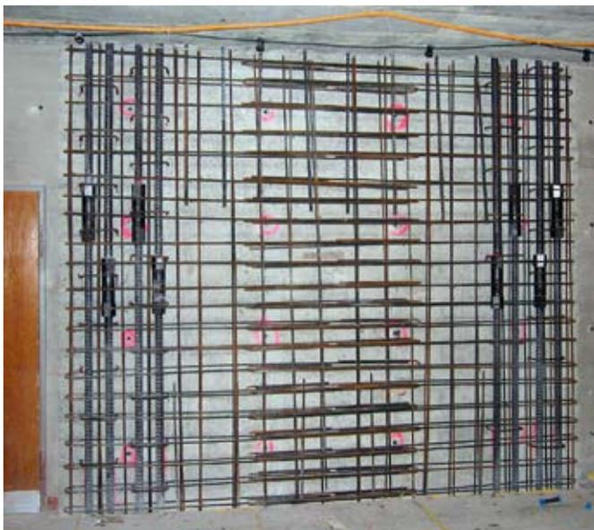
Armature d'une paroi accolée avec les liaisons de l'armature verticale.
