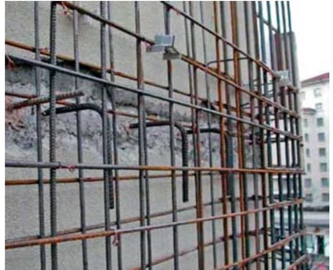
Détail d'armature d'une nouvelle paroi en béton armé avec les armatures de liaison scellées dans les dalles existantes.
