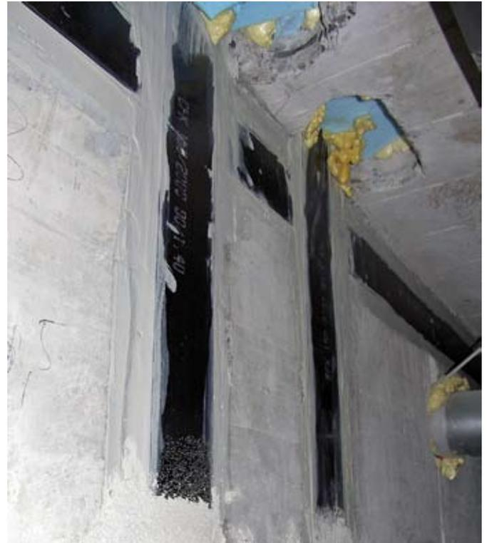
*Renforcement des noyaux d'ascenseurs avec des lamelles en fibre de carbone.*
