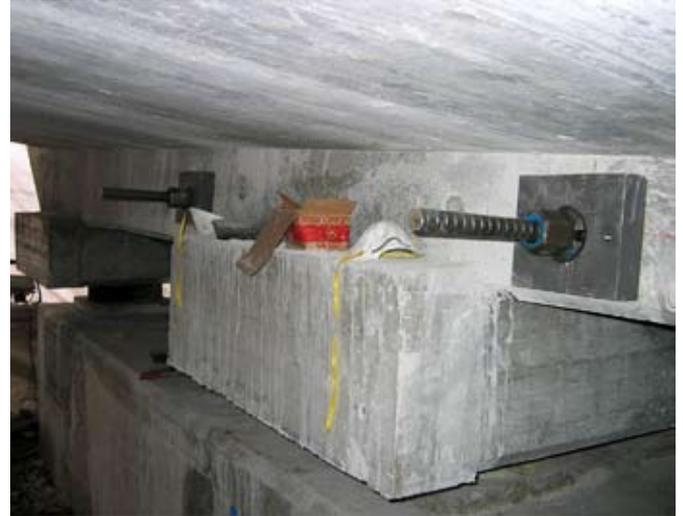
Solidarisation des deux moitiés du pont à la hauteur du joint de dilatation se trouvant initialement au milieu de l'ouvrage.
