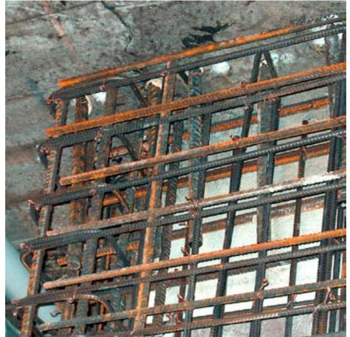
Armature de liaison entre les nouvelles parois en béton armé et les dalles existantes (Garcia-Vogel, 2005).
