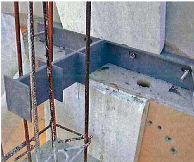
Élément d'acier en «T» servant à ancrer les nouvelles parois en béton armé dans les planchers existants.
