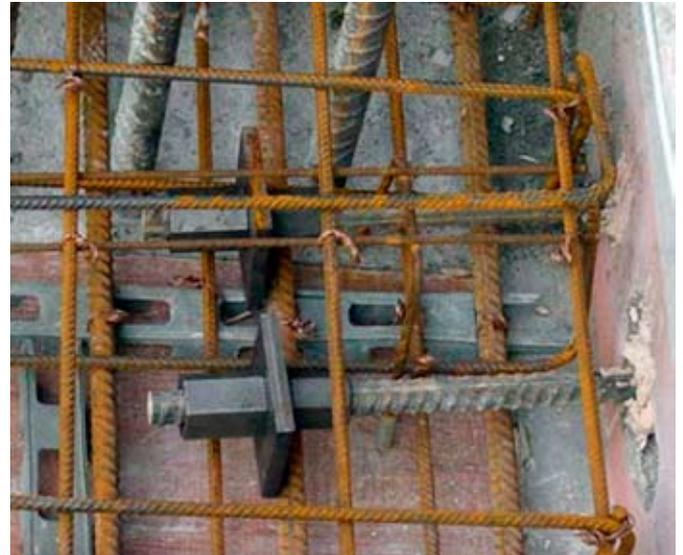
Ancrage du noyau d'ascenseur dans les dalles en béton armé existantes au moyen de barres Swiss-Gewi et d'une armature de répartition collée.
