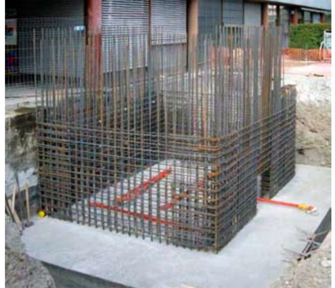
*Armature au sous-sol et fondation d'une nouvelle cage d'escalier.*
