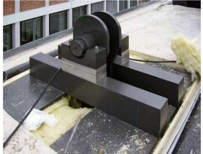
*Ancrage supérieur des éléments en fibres de carbone sur le toit, d'où ils sont précontraints.*
