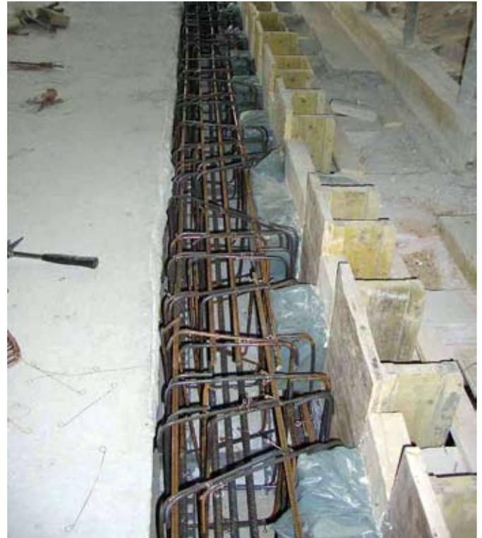
Armature d'ancrage des nouveaux planchers dans les parois en maçonnerie.
