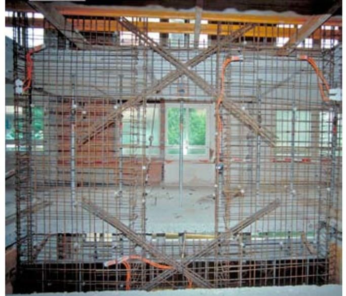
*Armature d'une nouvelle paroi couplée en béton armé au rez-de-chaussée, avec des barres diagonales dans les poutres de liaison.*
