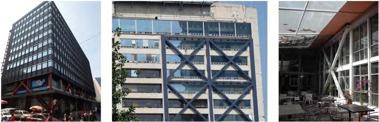
Figura 14-4 – Reforzamientos antisísmicos realizados sobre inmuebles existentes después de 1985.
