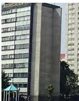
Figura 7 1 – Reforzamiento por muro de concreto
