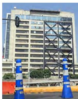
Figura 7 2 – Reforzamiento por contraviento metálico
