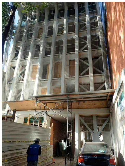
Figure 7-29 - Travaux de confortement en cours
