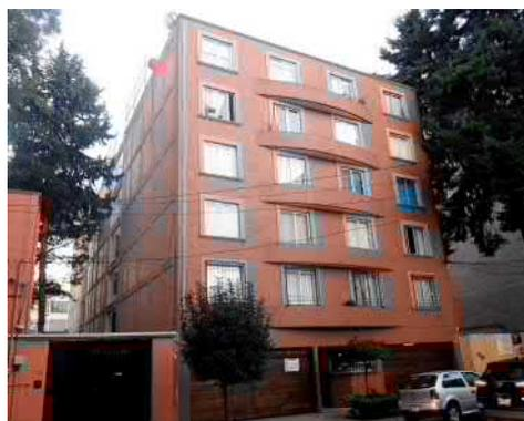
Figure 6-2 - Bâtiment avec structure poteaux-poutres en béton et remplissage maçonnerie
