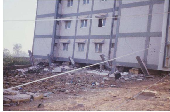
*Bhuj : l'effondrement des rez de chaussée*
