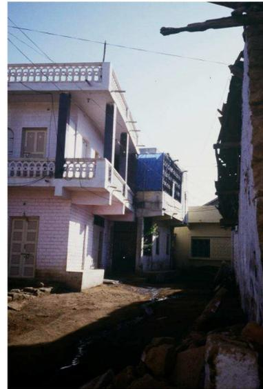
*Halvad (100 km de l'épicentre) : des constructions en maçonnerie avec un mortier de terre ruinées, des constructions en béton intactes*
