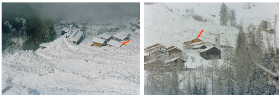
Figure 2. 5 Lourtier, Canton du Valais en Suisse, avalanche du 21 février 1999 (flèche rouge : construction récente intacte réalisée "conformément aux règles")
